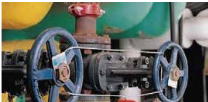
42301 标准缆绳锁具,不锈钢缆绳直径:2mm,可使用长度:1.8m
